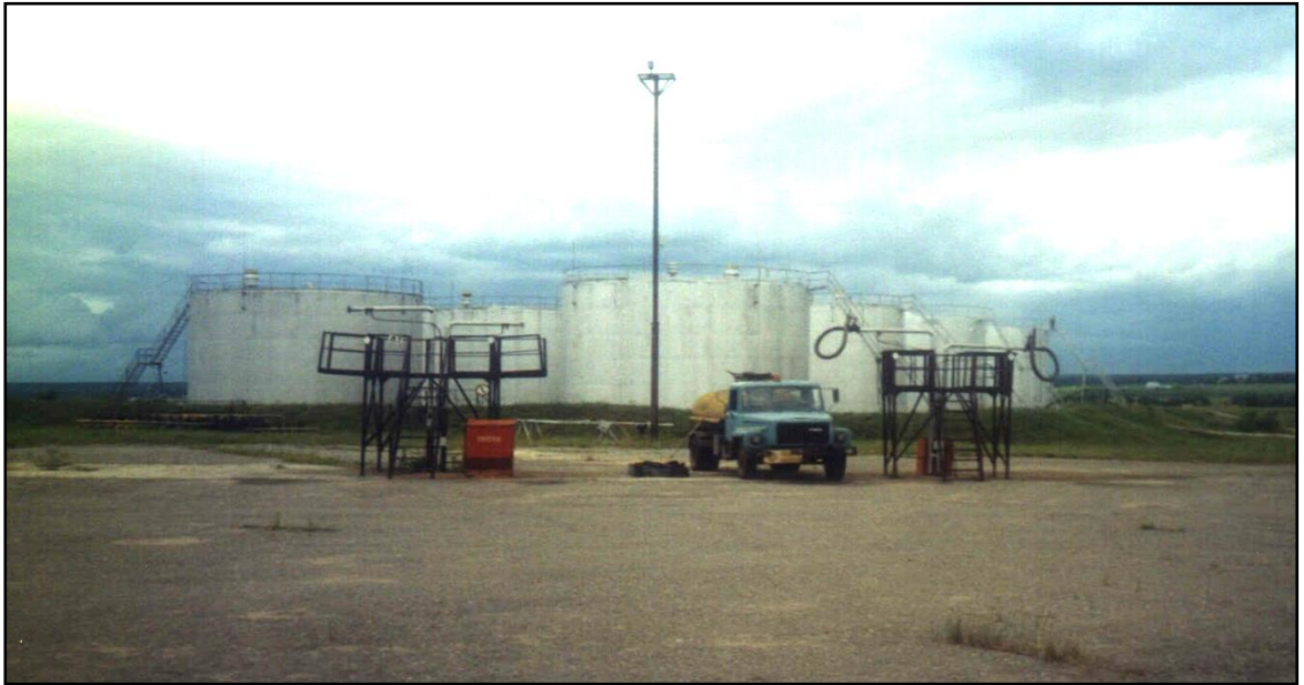
Рисунок 2.11 – Общий вид резервуарного парка нефтебазы
