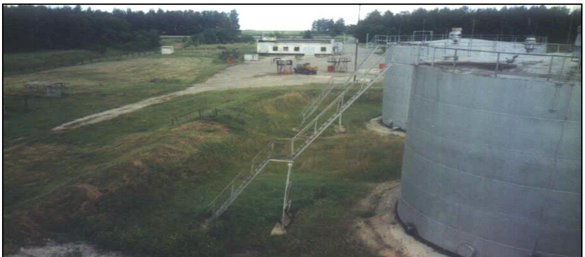
Рисунок 2.13 – Общий вид резервуаров в каре земляного обвалования
