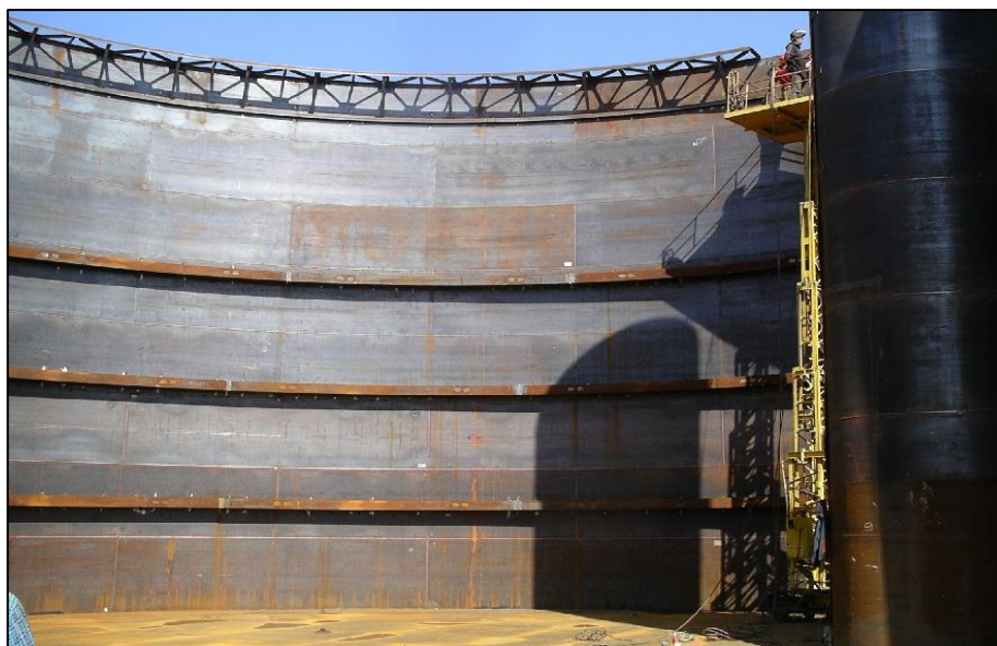
Рисунок 1.21 – Общий вид колец жесткости на защитной стенке
