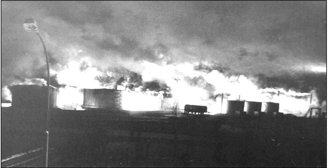
Рисунок 1.6 – Фрагмент каскадного развития пожара в резервуарном парке
