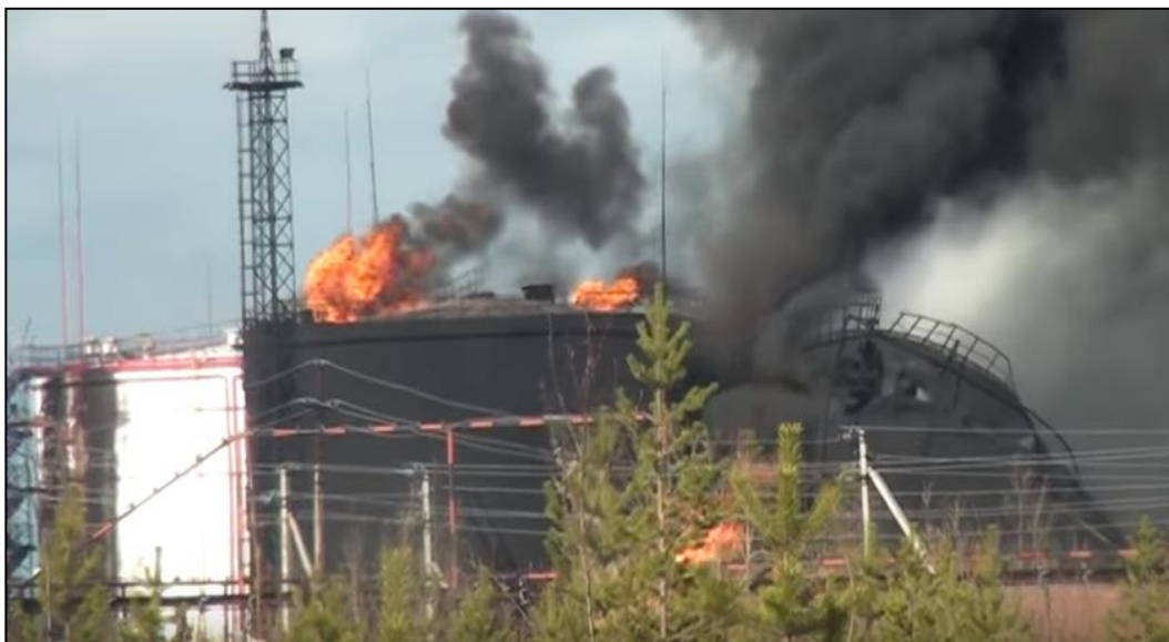
Рисунок 1.14 – Общий вид разрушенного РВС-5000 м 3
