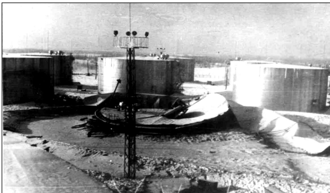
Рисунок 1.3 – Общий вид разрушенного РВС-5000 м 3
